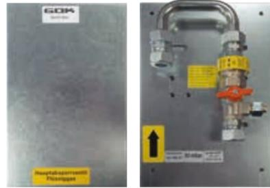
Hauptabsperreinrichtung im Hausanschlusskasten mit Kugelhahn u. Isolierstück
